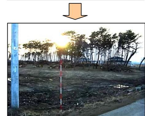
気仙沼市、東松島市における海岸防潮施設の流失・倒壊等の被災による浸水等防止のため、大型土のう積による応急対策および七ヶ浜町から山元町における海岸防災林の一部について、生育基盤盛土の準備として、ガレキ・倒木等の撤去を実施。
